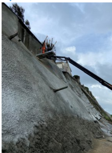
▼ Mise en oeuvre des drains
