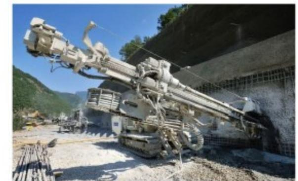
Réalisation d'un forage de paroi clouée avec foreuse
