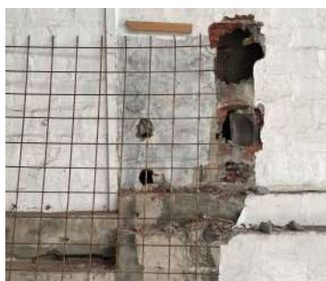
Des murs très abîmés sont refaits
