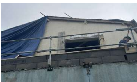
Construction du parapet pour la nouvelle terrasse du 1er étage
