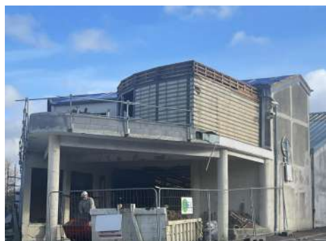
Préparation des murs extérieurs du 1er étage pour le futur bardage
