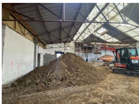
Une fois la dalle cassée et évacuée, le sol est décaissé et remis à l'horizontal
