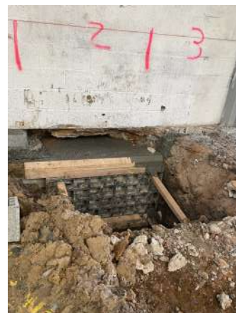
Reprise en sous-œuvre et renforcement des fondations de certains murs
