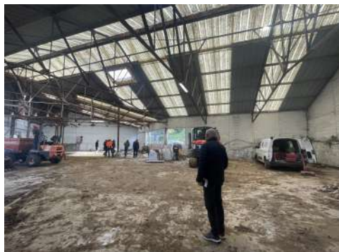
La grande salle entièrement vidée avec sa dalle initiale en pente qui doit être refaite
