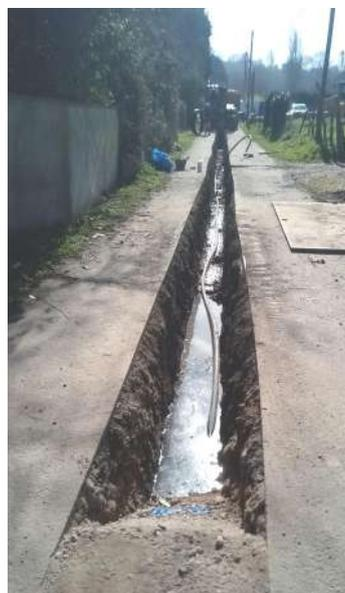
En avril dernier, plus de 400 mètres de canalisation d'eau ont été remplacés au Grand Bec (rue Mouillère) et sur la RD 513. Sur ce tronçon vétuste, plusieurs fuites avaient été constatées récemment, entraînant coupures d'eau et réparations successives.
