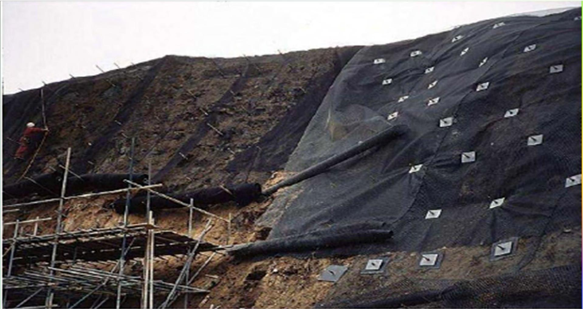
Les armatures, généralement métalliques, sont déposées perpendiculairement aux lignes de glissements éventuelles. La technique repose sur un transfert des efforts du sol vers les barres par mise en butée du terrain.
